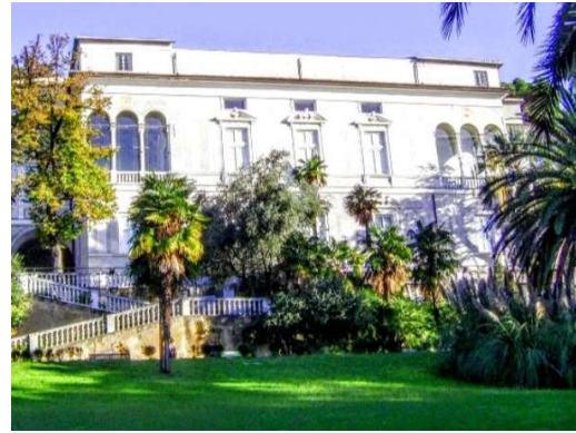
Figura 0.1 - Vista della facciata [esposta a Sud]
