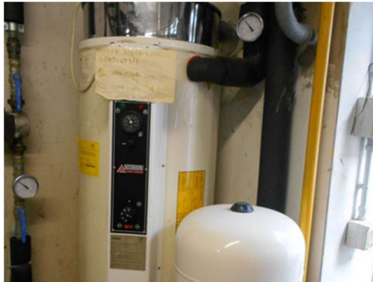
Figura 4.19 - Particolare dello scaldacqua a gas
